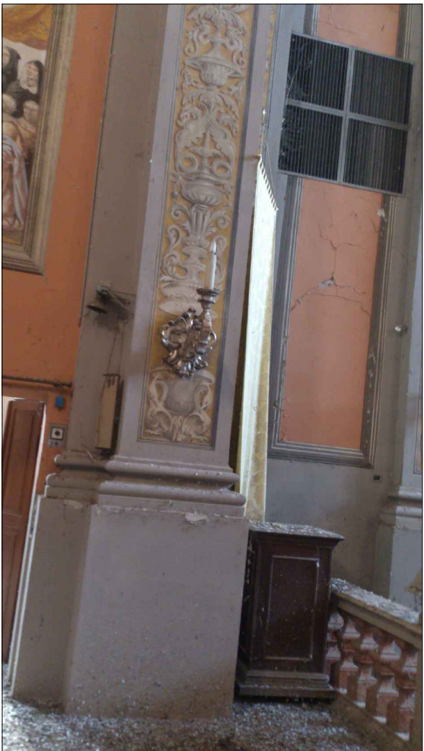
(**) FOTO STATO DI FATTO DELLA GRIGLIA DI MANDATA ARIA NON MODIFICATA. PREVISTO INTERVENTO DI PULIZIA E SANIFICAZIONE
