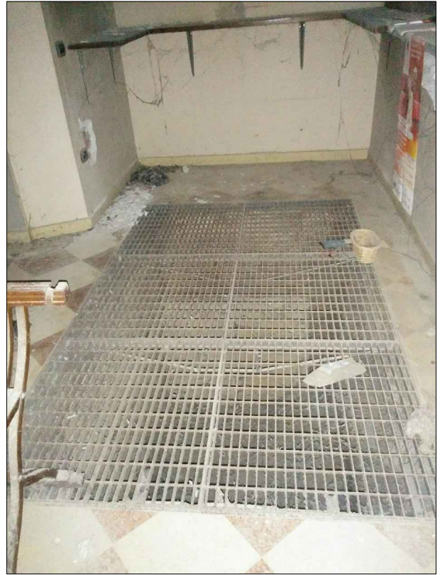
(***) GRIGLIA DI RIPRESA ESISTENTE DA SOSTITUIRE CON GRIGLIA ANTITACCO
